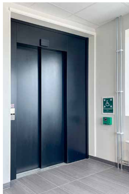
Figur 3. Apparät för tvåvägskommunikation placerad för nära innerhörn.
